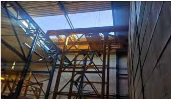
den lagert das Regal-Bediengerät, kurz RBG, die Produktionsstücke in den jeweiligen Positionen der Trockenkammer und holt sie danach wieder heraus. Für die Tauscharbeiten musste das Dach der Produktionshalle geöffnet werden. So konnte mit Hilfe eines Krans das alte Gerät herausgehoben und das neue eingehoben werden.
