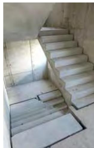
den Betonfertigteilstiegen geliefert – maßgenau gefertigt nach den Vorstellungen des Investors, versteht sich. Dank der schnellen Lieferung und der einfachen Montage konnte der Bau ohne Verzögerung realisiert werden.
