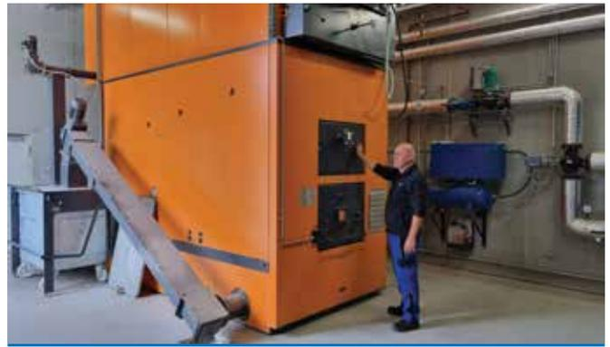
sel beheizt die Hallen 6 und 9, der kleinere die Halle 8 sowie das Büro und die neu errichtete Werkstatt. Aufgrund ihrer Größe war für die Installation beider Kessel eine Umweltschutzgenehmigung erforderlich. In Zukunft werden in diesen die Restmassen von nicht mehr verwendbaren Holzpaletten bzw. andere Holzrestmassen aus der Produktion thermisch verwertet. Das Ganze geschieht ohne zusätzliche Transportwege und die gewonnene Energie kann direkt vor Ort wiederverwertet werden.
