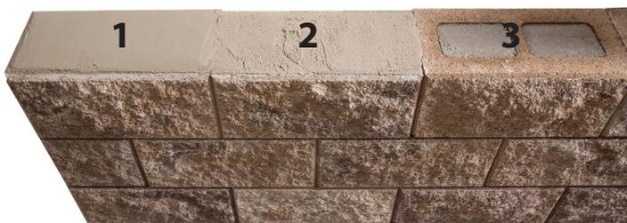
1 = Feuchteschutz vollflächig mittels Dichtungsschlämme hergestellt.
